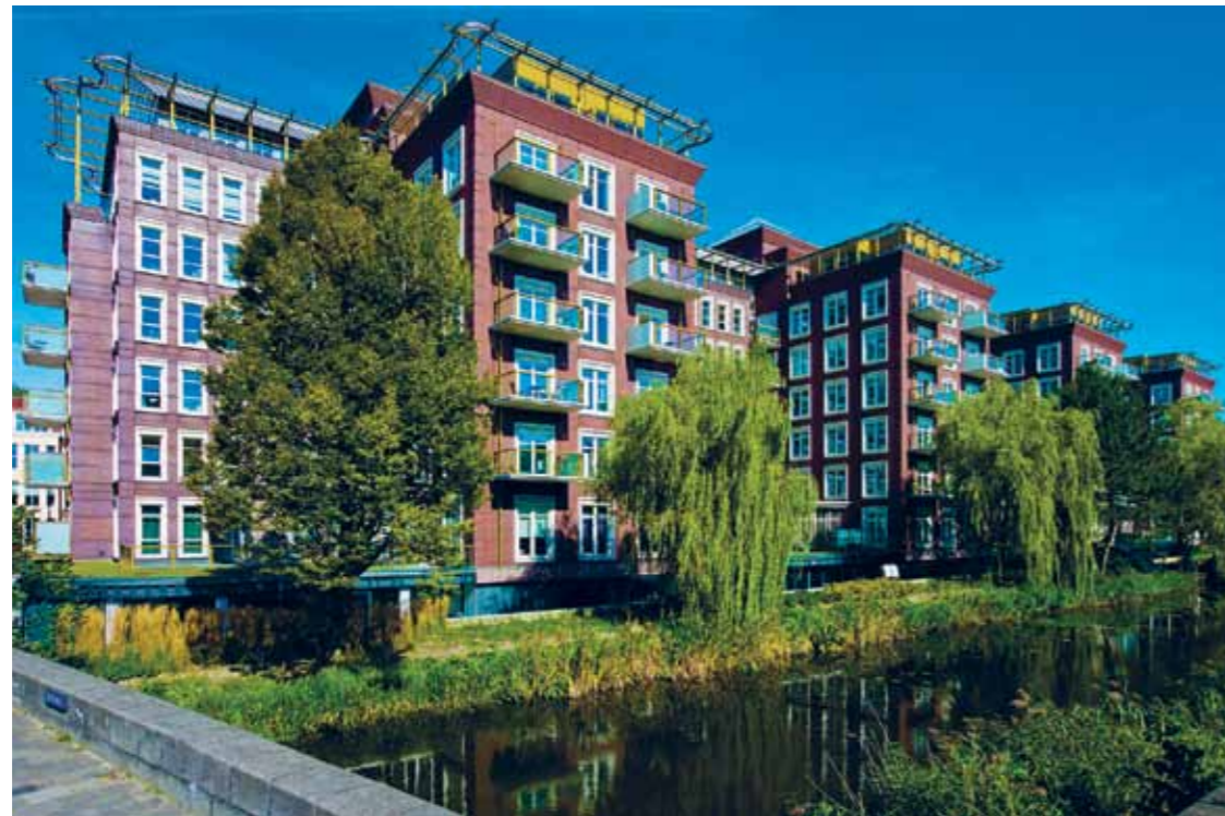
1_Eigentijdse appartementen in het voormalige kantoorgebouw Molenwerf. 2_Betaalbare huurwoningen in de nieuwe wijk Emerald.
