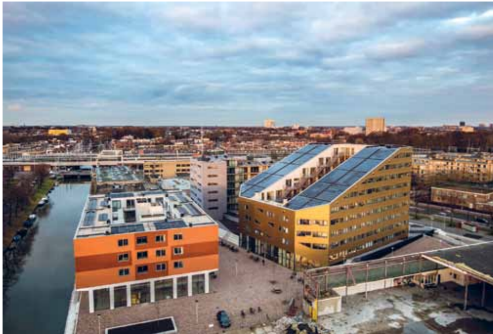
2 De Trip. Voor Jebber zijn door Klimaatgarant in samenwerking met Volker Wessels 253 huurappartementen voor starters gerealiseerd. 3 Uphill. In samenwerking met Klimaatgarant heeft Jansen de Jong projectontwikkeling het mogelijk gemaakt dat deze zeer duurzame woningen niet zijn aangesloten op het stadsverwarmingsnet.
