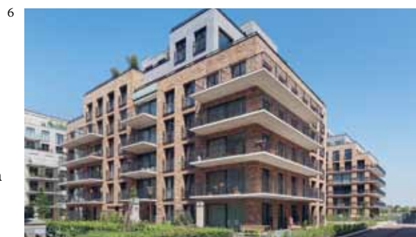
6_Overhoeks Halve Maen; onderdeel van Bouwinvest Dutch Institutional Residential Fund N.V. Partners:Ymere, Architect: Mecanoo Architecten. 7_Houthaven; Co-makingship met woningcorporatie Ymere. Architect: Svetla Stefanova. 8_NoMA House; initiatief van Maarsen Groep en Beheer Brouwershoff. Architect: Dam en Partners Architecten. 9_AM4; datacenter van Equinix. Bouwcombinatie Unica Dura Vermeer. Datacenters bestaande uit Unica en Dura Vermeer. Architect: Benthem en Crouwel Architects.
