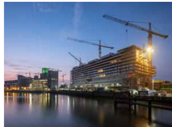
Fenixloodsen I, Rotterdam
