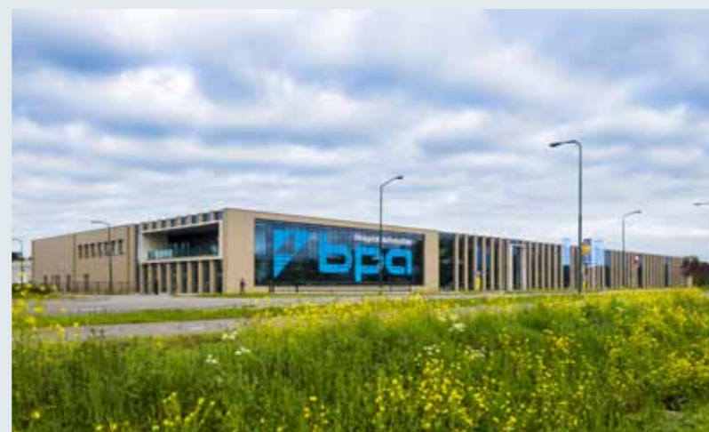
Nieuwbouw bedrijfsgebouw BPA te Woerden
