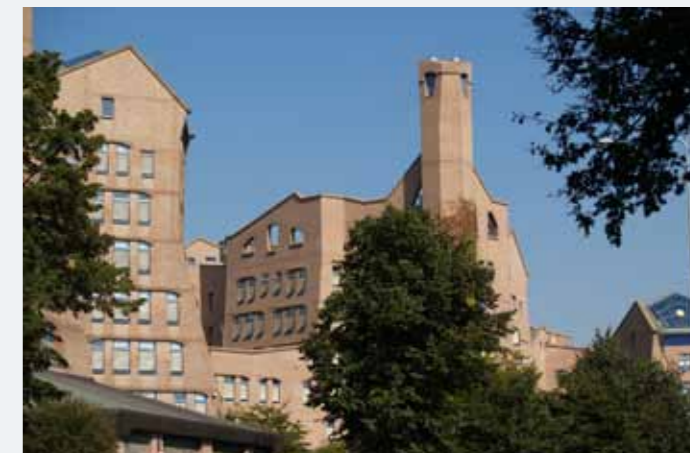
Hoofdkantoor ING-bank Amsterdam Zuidoost. Transformatie naar appartementen, internationale school en commerciële functies, waaronder restaurants.
