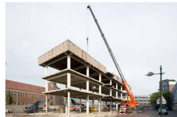
Strippen voormalig Rabobank kantoor
