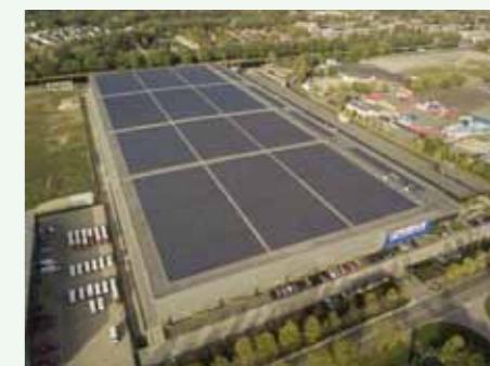
Panelenveld op het dak van Rhenus Logistics in Eindhoven. Daar wekken ruim 15.000 panelen elk jaar 4.000.000 kWh op.
