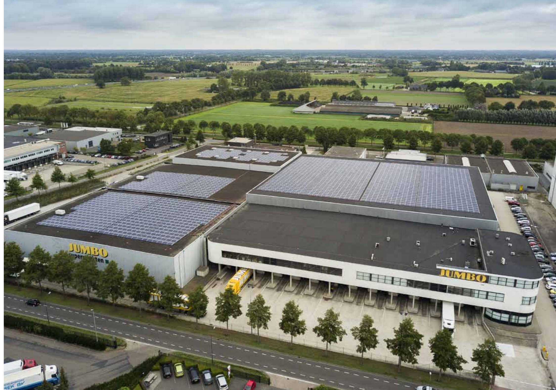
Eén van de zonnedaken van Jumbo Supermarkten in Veghel. 4.784 zonnepanelen wekken in totaal 1.200.000 kWh per jaar op.
