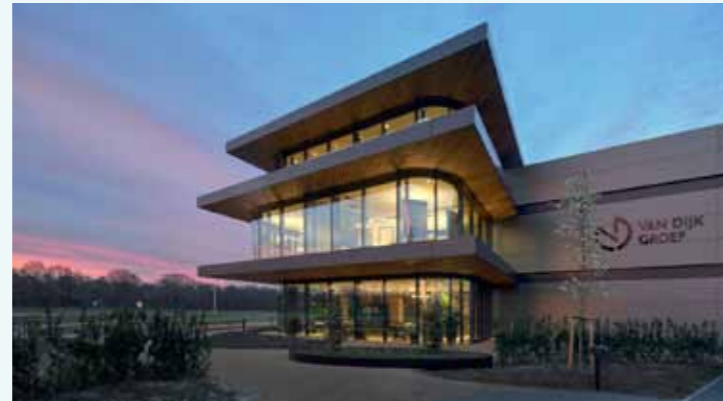
Links en boven het nieuwe hoofdkantoor in Gemert. Een volledig energieneutraal pand.
