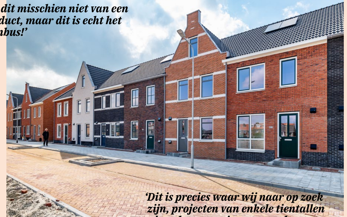
links, rechts en onder 21 energiezuinige vrije-sector- huurwoningen in Vlissingen
