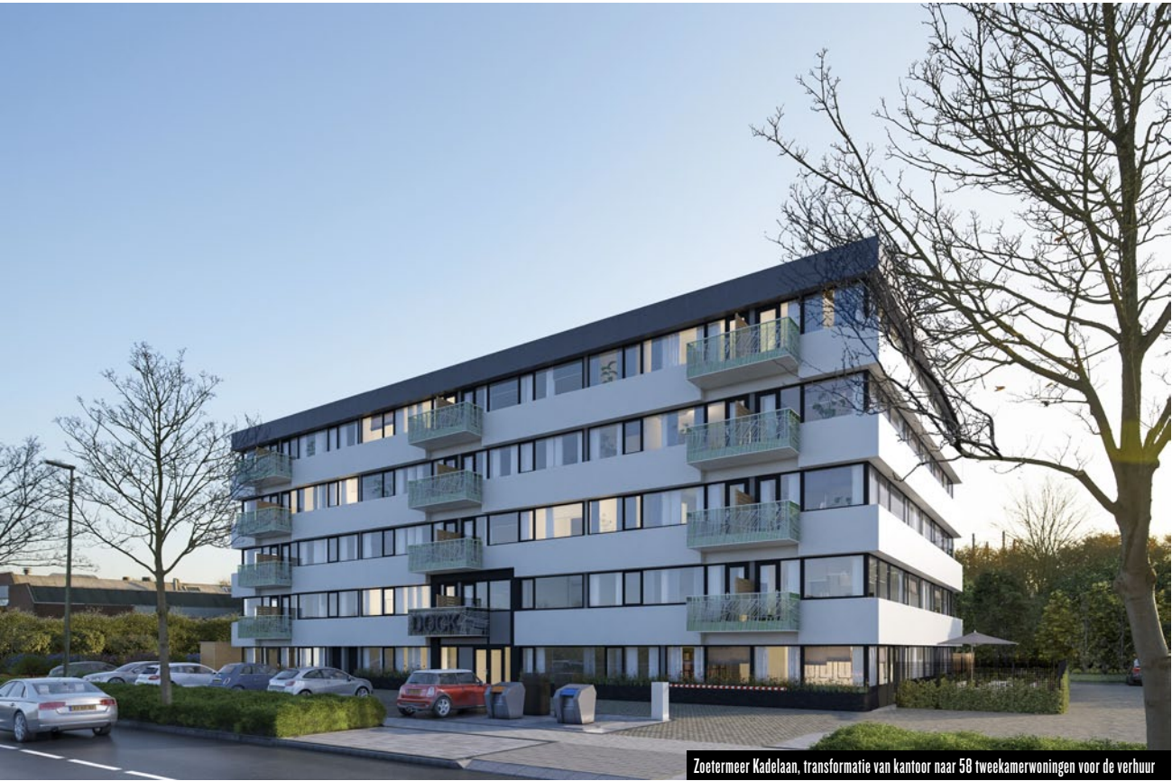
Zoetermeer Kadelaan, transformatie van kantoor naar 58 tweekamerwoningen voor de verhuur
