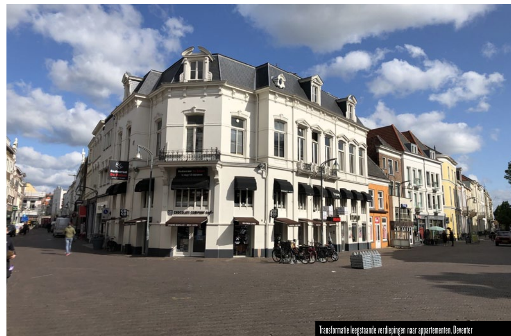
Transformatie leegstaande verdiepingen naar appartementen, Deventer
