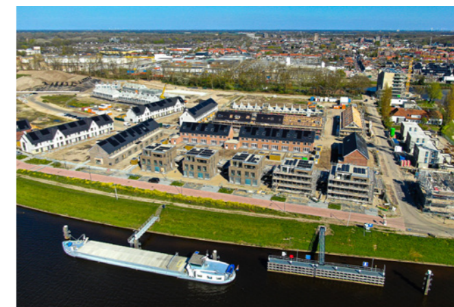
Oosterhout; 12 woningen, project Slotjes
