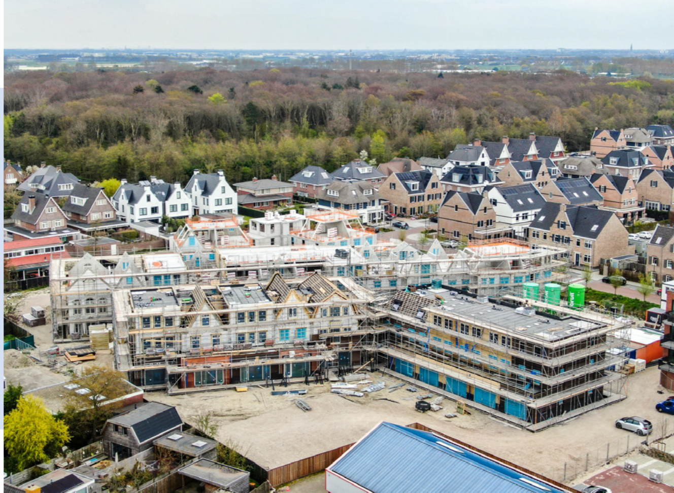
Noordwijk; 28 woningen, project Offem Zuid West
