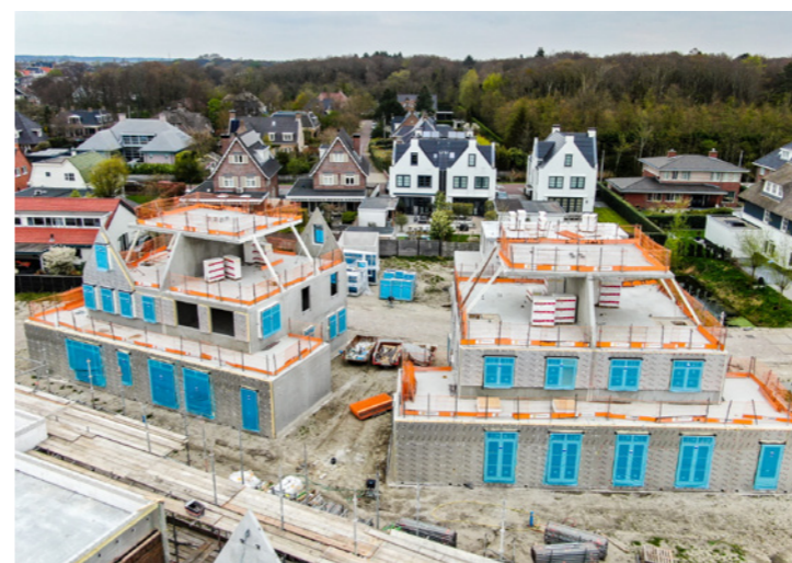
Noordwijk; 28 woningen, project Offem Zuid West
