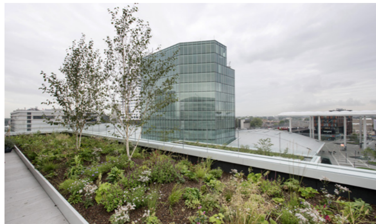
Daktuin Het Platform in Utrecht
