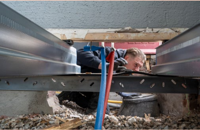
Volledige vloer vervanging Project Statenkwartier Arnhem
