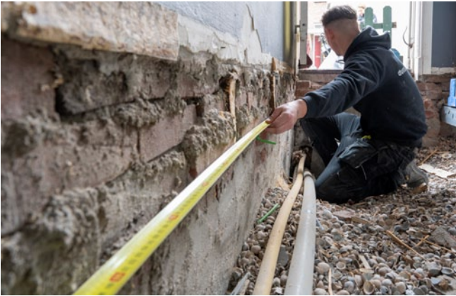
Volledige vloer vervanging Project Statenkwartier Arnhem
