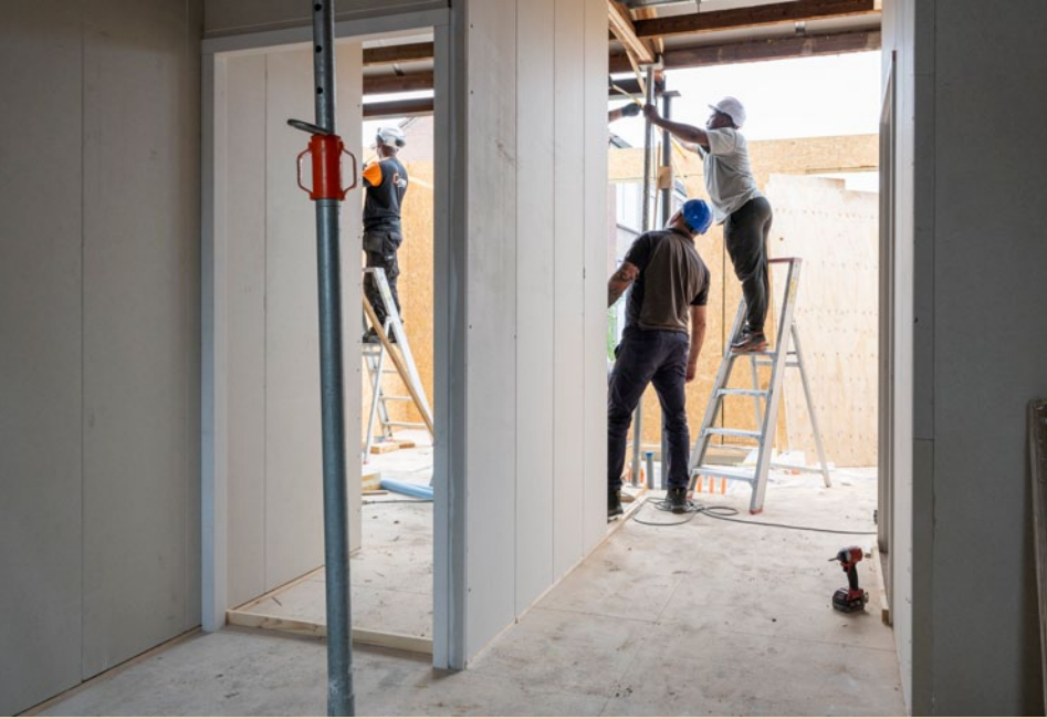
Wandsysteem met vlas isolatie erin verwerkt Circulair Renovatieproject Oranjeplein Meerkerk
