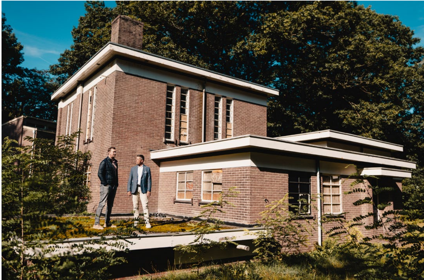
'Casa Acqua', voormalige Vitens waterproductielocatie Soest, getransformeerd tot zes woningen
