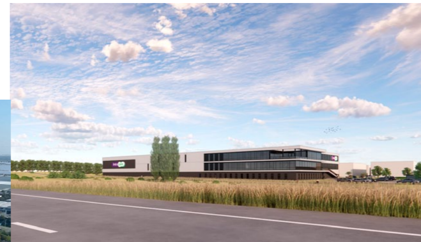
Bedrijfsgebouw Intracare in Veghel gaat binnenkort gerealiseerd worden
